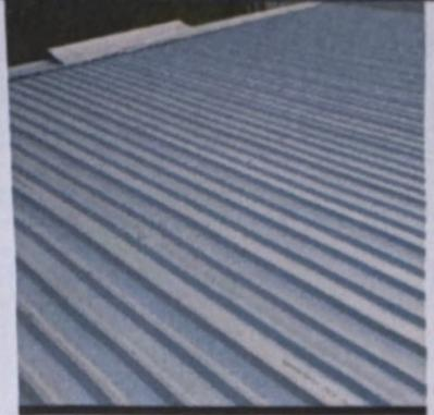
Foto1: sustitucion de lamina por lamina troquelada de aluzinc calibre 26
