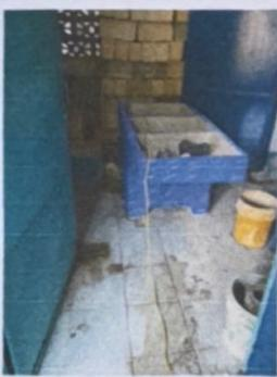
Foto 5: sustitucion de pila de cemento de dos lavaderos
