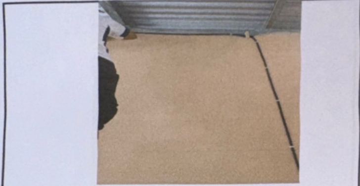
Foto 3: reparacion de cableado principal
