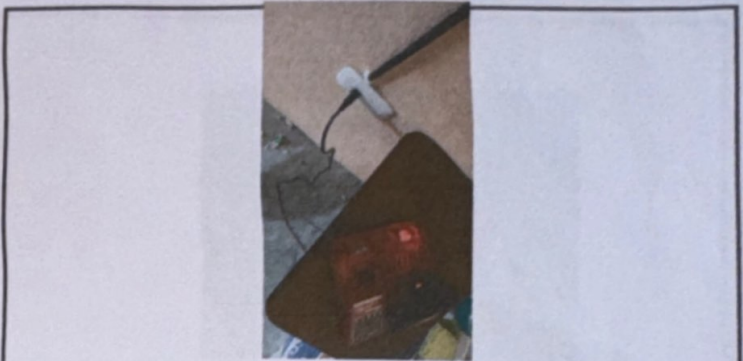
Foto 4: sustitucion de accesorio electricos
