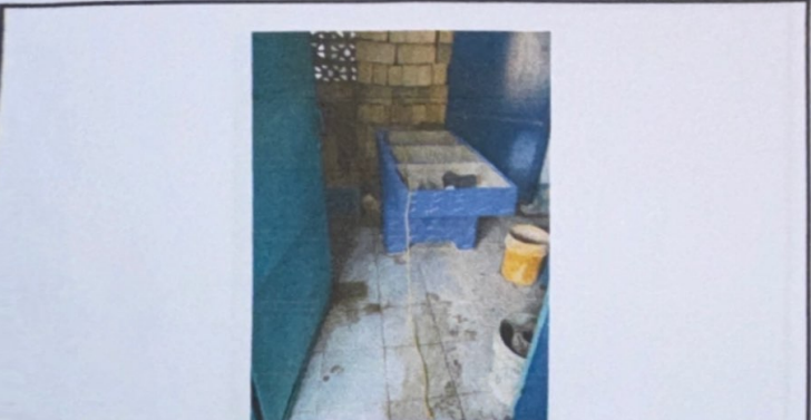
Foto 5: sustitucion de pila de cemento de dos lavaderos
