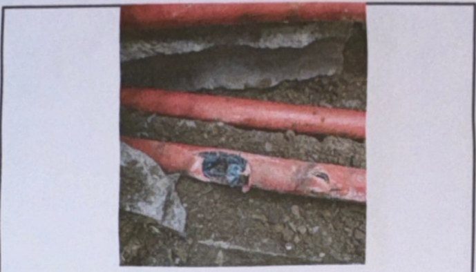
Foto 3: reparacion de cableado principal
