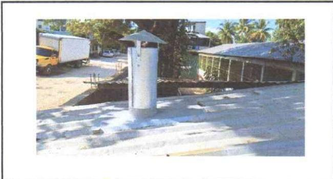
Foto 3: Sustitución de Chimenea de metal
