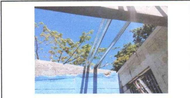
Foto 3: Mantenimiento de estructura de soporte de madera por metal
