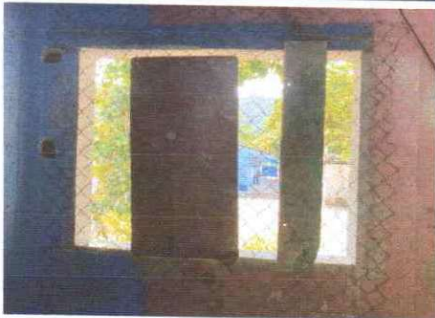
Foto 5: Fabricación e instalación de ventanas-balcon de metal
