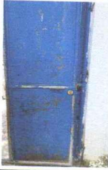
Foto 1: Mantenimiento a porton de metal
