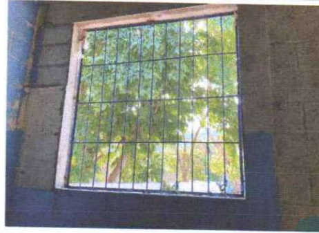
Foto 2: Fabricación e instalación de ventanas-balcon de metal
