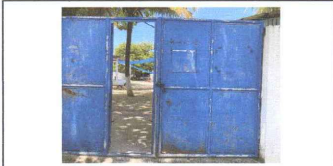
Foto 5: Mantenimiento a porton de metal
