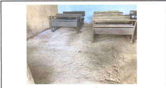
Foto 3: Reparación de torta de concreto
