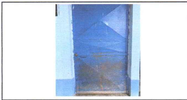
Foto 5: Mantenimiento de puerta
