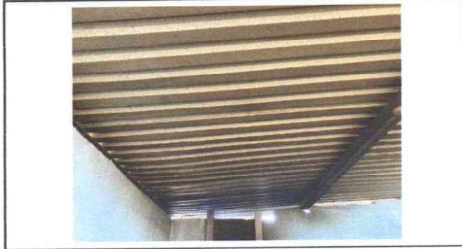
Foto 2: Mantenimiento de estructura de soporte de metal
