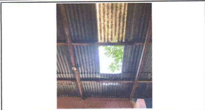
Foto 1: Sustrucción de lámina troquelada
