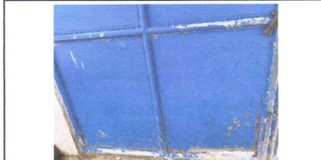
Foto 6: Mantenimiento a porton de metal
