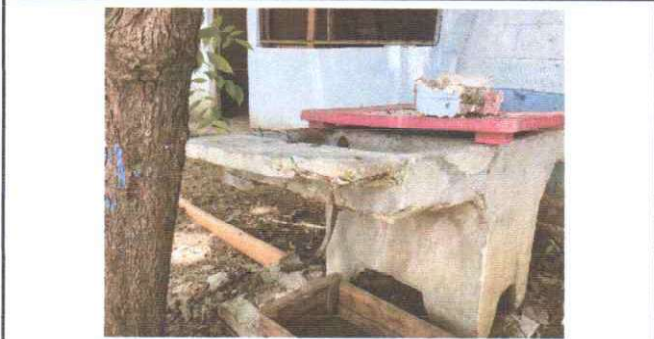
Foto 1: Sustitución de pila de cemento de 2 lavadores
