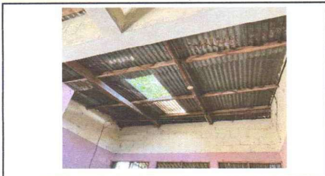
Foto 3: Mantenimiento de estructura de soporte de madera por metal
