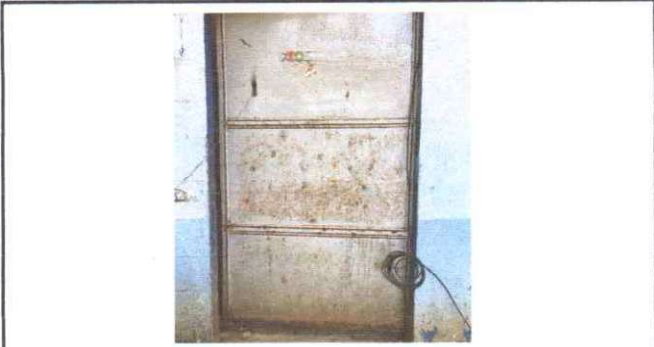
Foto 1: Mantenimiento de puerta
