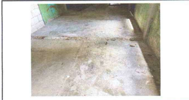
Foto 4: Reparación de torta de concreto
