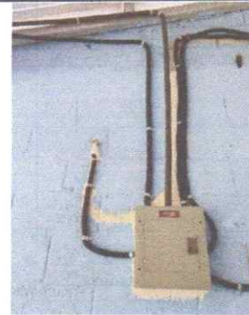
Instalación de tablero y Flipones
