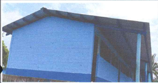
Sustitución de lámina troquelada de aluzinc.
