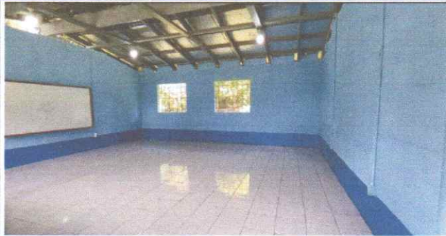
Sustitución de piso cerámico.
