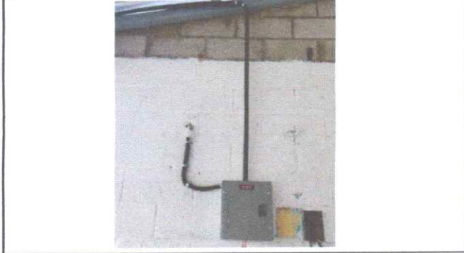
Instalación de tablero y Flipones
