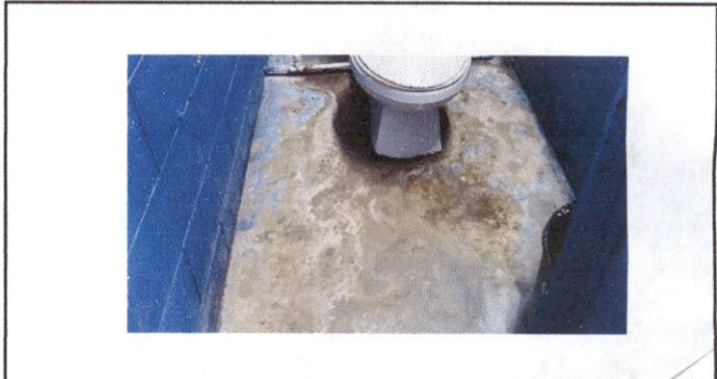
Foto 4: Reparacion de piso, torta de cemento en servicios sanitarios
