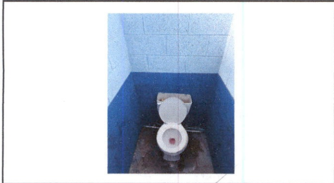
Foto 1: Sustitucion de inodoros
