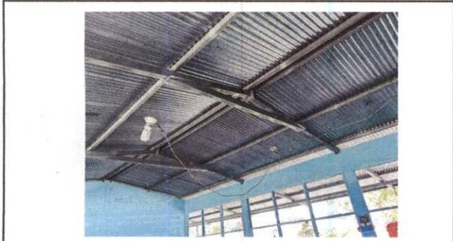
Foto 3: Reparacion de sistema electrico
