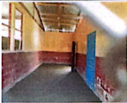
reparación de piso de torta de concreto
