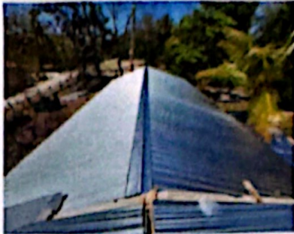
sustitución de lamina por lamina troquelada calibre 28
