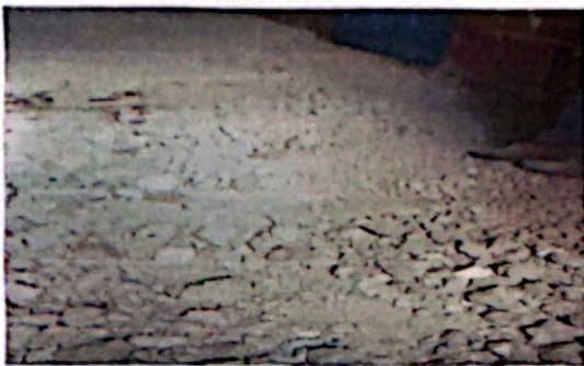
reparación de piso de torta de concreto
