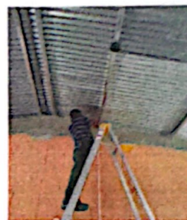
reparación de cableado eléctrico
