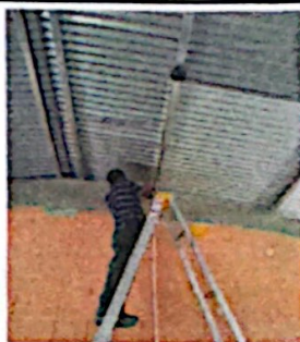
sustitución de focos ahorradores
