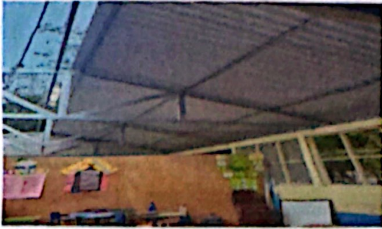
sustitución de lamina por lamina troquelada calibre 26
