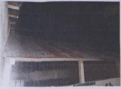
sustitución de lamina por lamina troquelada calibre 26
