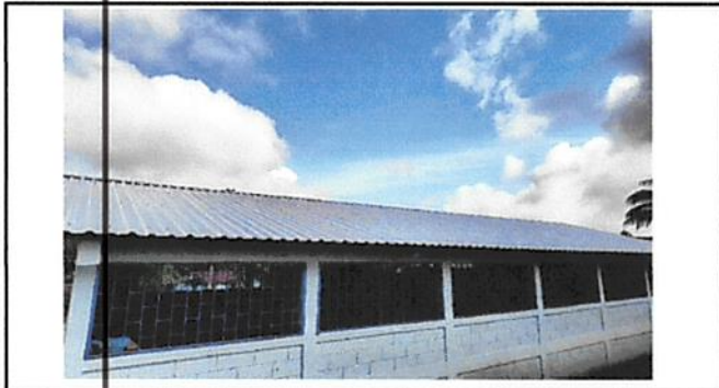
Foto 3: SUSTITUCION DE LAMINA TROQUELADA ALUZINC CALIBRE 26
