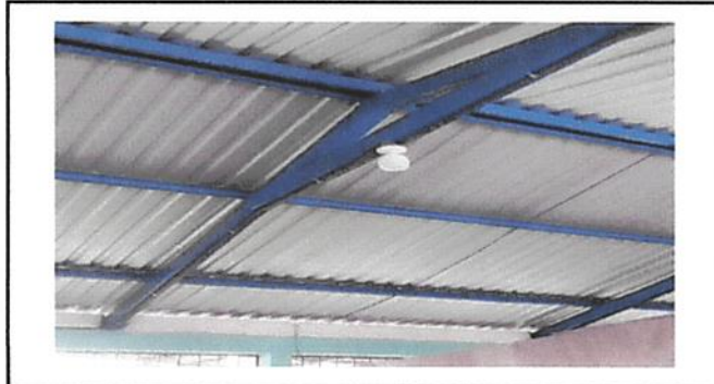
Foto 2: INSTALACIÓN DE UNIDADES DE FUERZA
