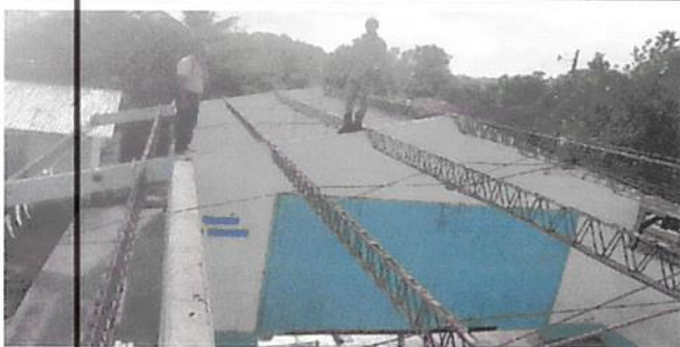
Foto 5: SUSTITUCION DE ESTRUCTURA DE SOPORTE DE METAL POR METAL
