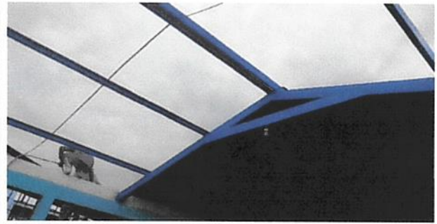
Foto 2: SUSTITUCION DE CAPOTE DE LAMINA PARA LAMINA TROQUELADA
