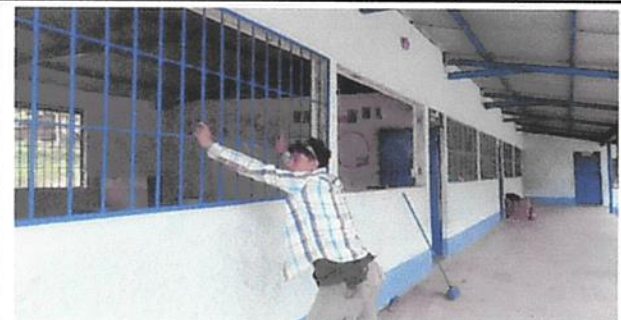
Foto 6: MANTENIMIENTO BALCONES DE METAL
