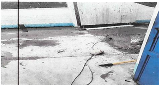
Foto 3: SUSTITUCION DE ELEMENTOS DE FIJACION
