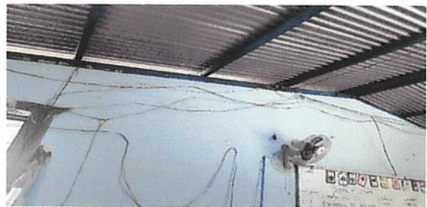
Foto 4: INSTALACION DE UNIDADES DE FUERZA
