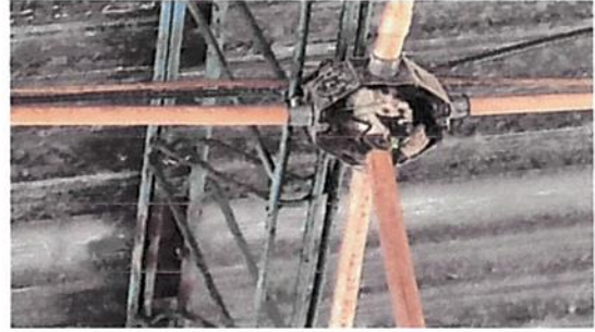
Foto 4: INSTALACION DE UNIDADES DE FUERZA
