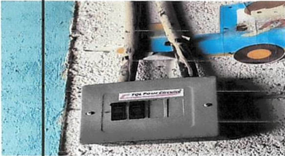
Foto 3: SUSTITUCION DE TABLERO DE FLIPONES
