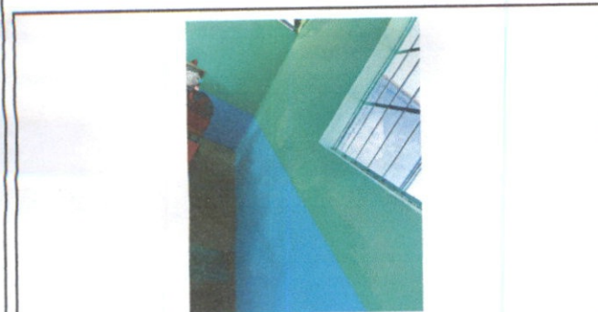
Foto 5: Pintura de muros interiores y exteriores
