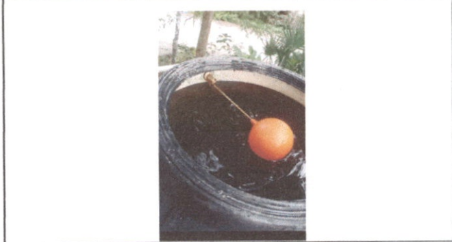
Foto 2: Reparacion y mantenimiento de depositos de agua
