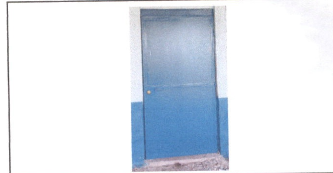
Foto 6: Sustitucion de puera de madera por metal
