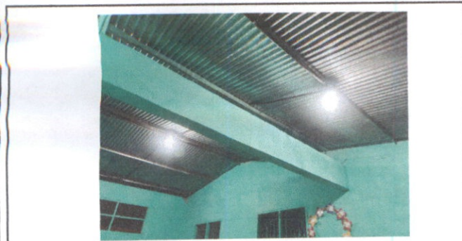
Foto 3: Reparacion de sistema electrico
