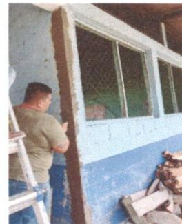
Foto 6: Sustitucion de puera de madera por metal
