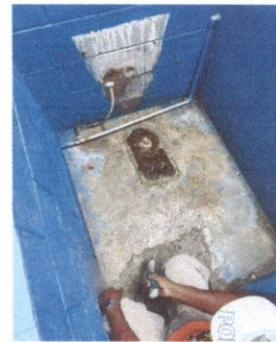
Foto 4: Reparacion de piso, torta de cemento en servicios sanitarios
