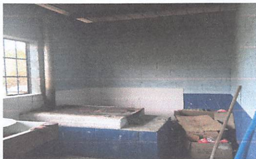
MANTENIMIENTO A ESTUFA RURAL
