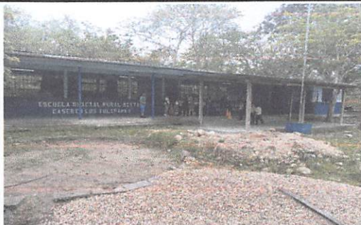
SUSTITUCIÓN DE LAMINA, POR LAMINA TROQUELADA ALUZINC CALIBRE 26
