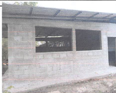
PINTURA EN MURO EXTERIOR E INTERIOR
