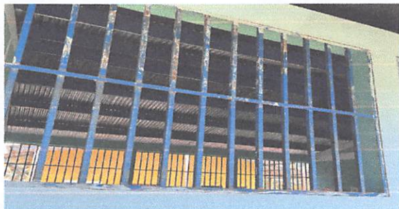
SUSTITUCIÓN DE BALCON DE METAL POR METAL
