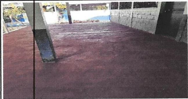
Foto 1: Sustitución de torta de concreto
