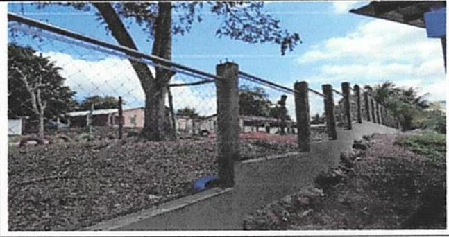
Foto 6: Solera intermedias y columnas
