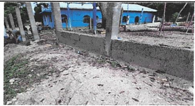
Foto 6: Solera intermedias y columnas
