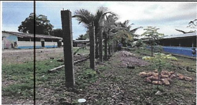
Foto 5: Reparación de tubo hg y malla galvanizada
