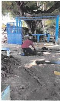
Foto 3: Mantenimiento a portón de metal
