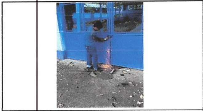
Foto 9: Sustitución de chapas
