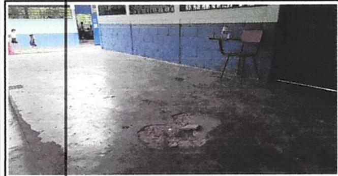
Foto 1: Sustrucción de torta de concreto
