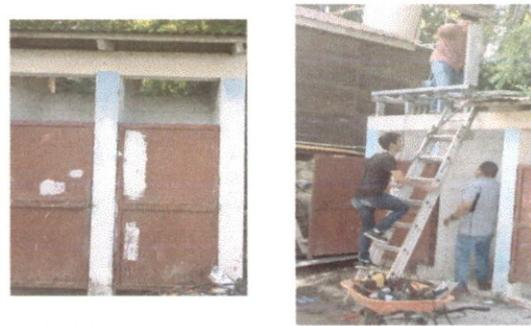
COMO PODEMOS OBSERVAR EN ESTA IMAGEN EL PROCESO DE COLOCAR UN DEPOSITO CON AGUA PARA USO DE LOS BAÑOS
