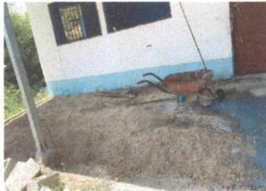
ES ESTE PROCESO PODEMOS OBSERVAR QUE SE VA A REALIZAR EL PPROCESO DE COLOCACIÓN DE BLOCK Y SE REALIZARA UNA TORTA O PISO RUSTICO
