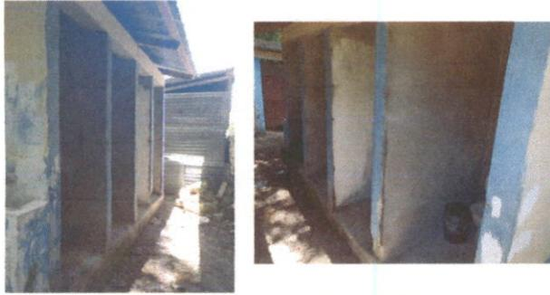
COMO SE QUEDE OBSERVAR EN LA FOTO EL TRABAJO DE REPARACIÓN DE PUERTAS DE BAÑO YA SE QUITARON PARA REALIZAR EL PROCESO RESPECTIVO DE REPARACION Y LIJADO Y
