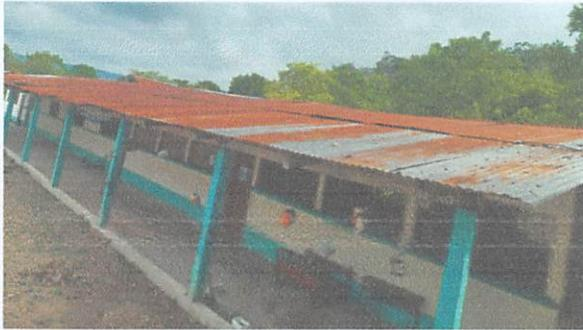
**Foto 1: Como podemos observar las aulas necesitan cambio de estructura metalica y lámina**
