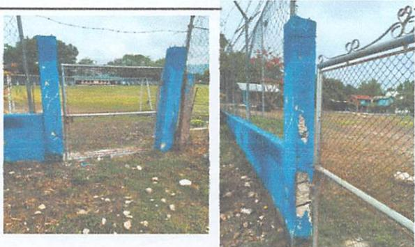
**Foto 5: Este se necesita remodelar las dos columnas ya que se encuentra deterioradas**
