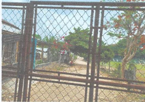
**Foto 4: Podemos Observar el portón necesita cambio de malla ya que contiene agujeros**
