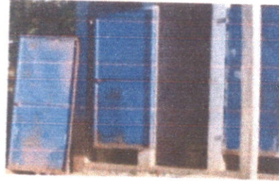
Foto 2: sustitución; puerta de los baños
