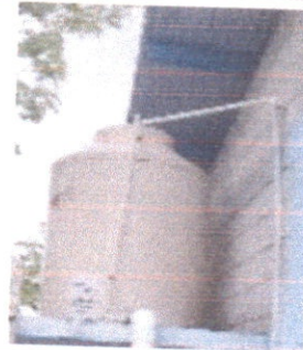
Foto 8: sustitución de depósito de agua
