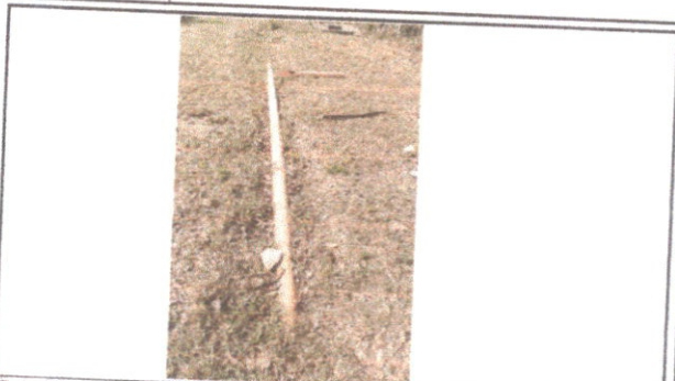
Foto 14: sustitución de tubería de aguas negras
