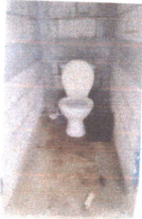
Foto 7: sustitución de inodoros (tasas)
