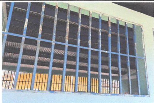
SUSTITUCIÓN DE BALCON
