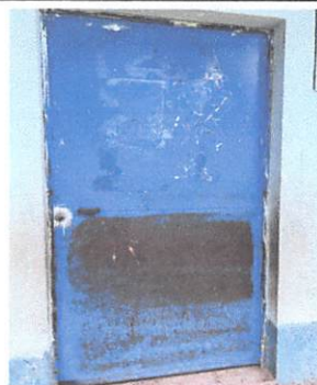
SUSTITUCIÓN DE PUERTA
