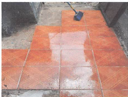
SUSTITUCION DE CERAMICA
