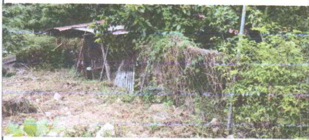
Es la parte de la maya y tubo galvanizado que se va a remozar, el cual tiene una base de tres hiladas de bock
