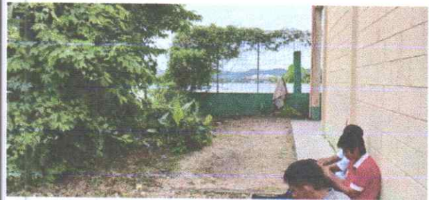
Se describe la parte inconclusa de la muralla perimetral
