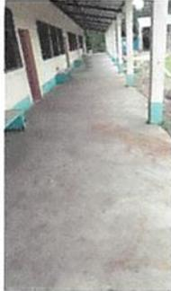
Foto 1: Sustitución Piso de torta de concreto
