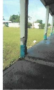
Foto 2: Sellado de grietas y fisuras en muros
