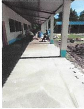
Foto1: Sustrución Piso de torta de concreto
