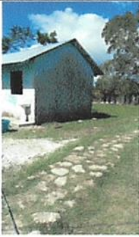
Foto 3: Pintura de muros exteriores e interiores
