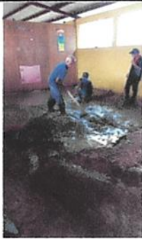
Foto1: Sustrución Piso de torta de concreto
