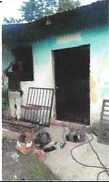
Foto1: Sustitución de balcones de metal
