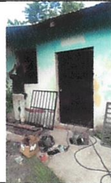
Foto 2: fabricación e instalación de puerta de rejas
