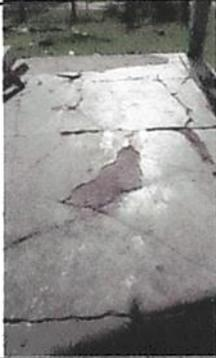
Foto 1: Sustrucción de piso de torta de concreto
