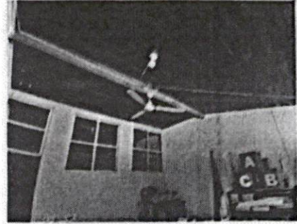
Foto 2: Reparación cableado eléctrico
