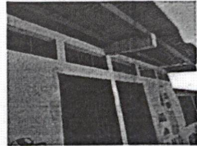
Foto 4: Fabricación de ventanas
