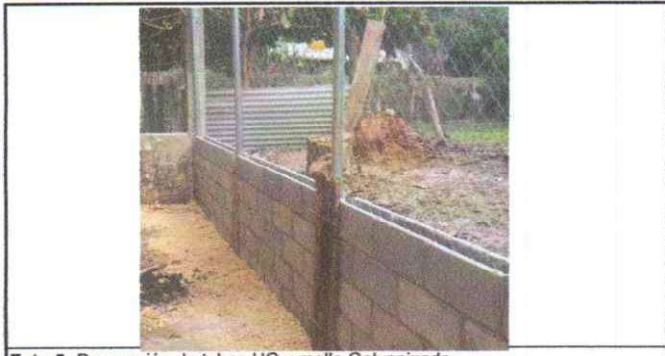
Foto 5: Reparación de tubos HG y malla Galvanizada
