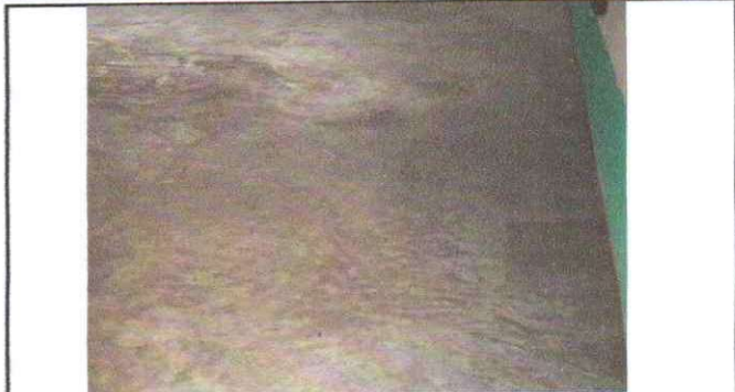
Foto 2: Sustitución de piso torta de concreto
