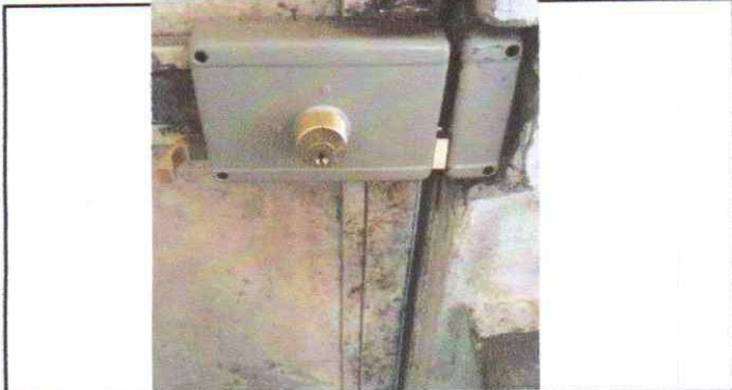
Foto 1: Sustitución de chapa
