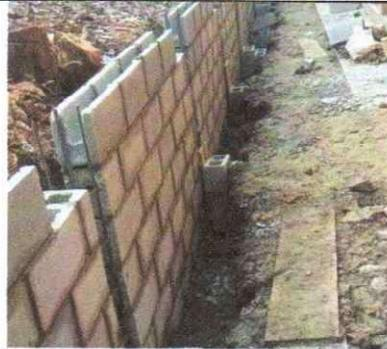
Foto 4: Reparación de muro perimetral de block
