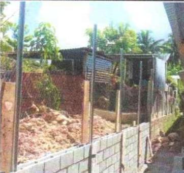
Foto 5: Reparación de tubos HG y malla Galvanizada
