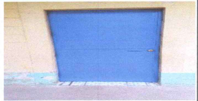
SUSTITUCIÓN DE PUERTAS EN SERVICIOS SANITARIOS
