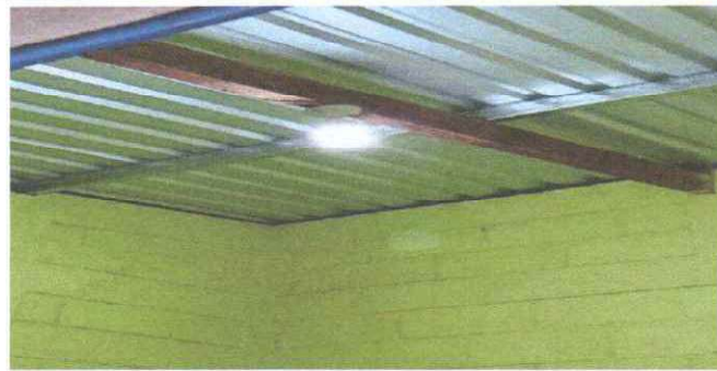
SUSTITUCIÓN DE PLAFONERAS
