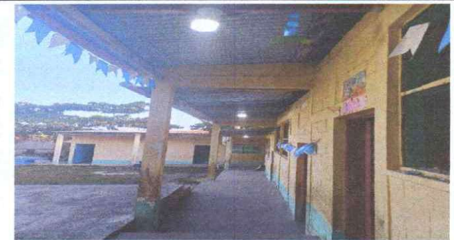
SUSTITUCIÓN DE LAMPARA AHORRADORA
