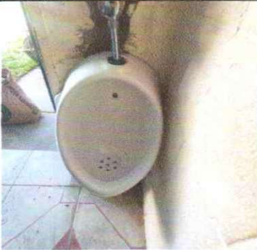
Foto 3: Sustitución de migitorio
