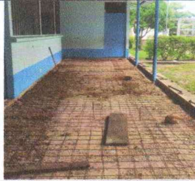
Foto 4: Sustitución de piso torta de concreto
