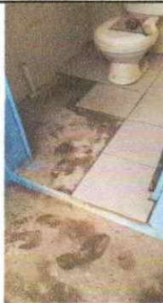
Foto 5: Sustitución de piso cerámico
