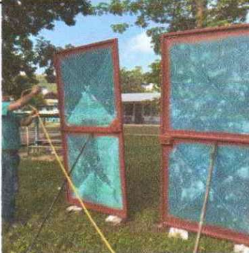
Foto 1: MANTENIMIENTO A ESTRUCTURA PUERTA DE METAL (lijado, cambio de tubo, cepillado, sujeciones, aplicación de pintura)
