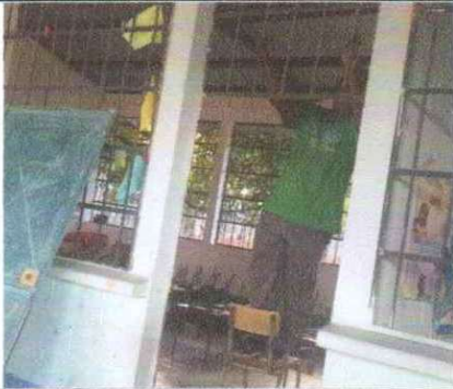
Foto 3: Mantenimiento a balcones de metal
