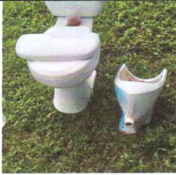
Foto1: Sustitución de accesorios para hinodoro.
