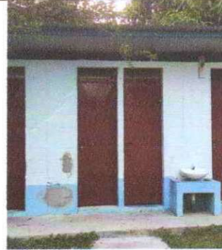
Foto 2: Sustitución de lavamanos
