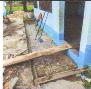
Foto 6: Reparación de banquetta de concreto
