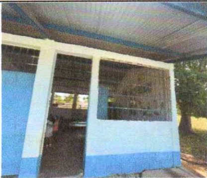
Foto 3: Mantenimiento a balcones de metal
