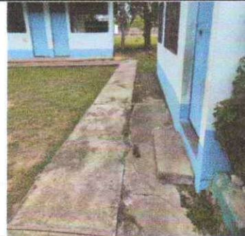
Foto 6: Reparación de banqueta de concreto
