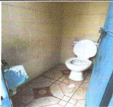
Foto 5: Sustitución de piso cerámico
