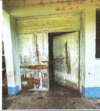
Foto 2: Sustitución de puerta
