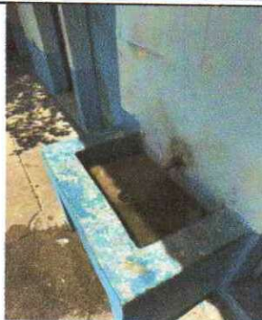
Foto 2: Sustrucción de lavamanos
