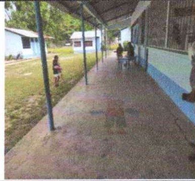
Foto 4: Sustitución de piso torta de concreto
