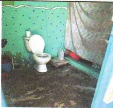
Foto 1: Sustrucción de accesorios para hinodoro.
