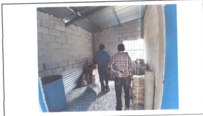
Foto 9: Interior de cocina
