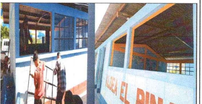
Foto 6: Sustitucion de estructura de metal de ventana
