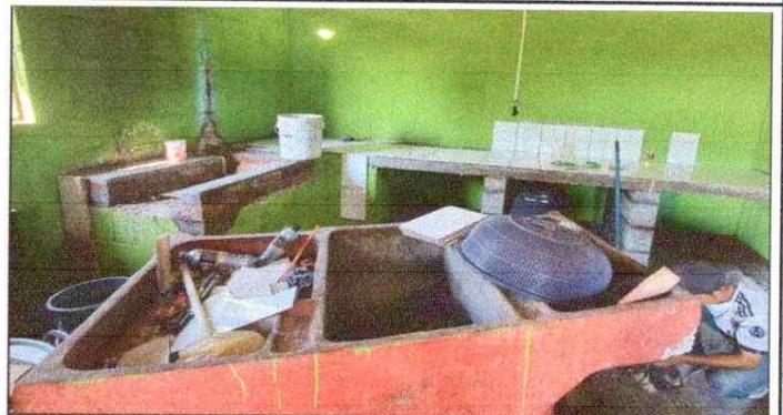
Foto 2: Mejoramiento de pila de concreto en cocina e instalacion de drenajey accesorios pvc, instalacion de tuberia llaves y accesorios pvc.
