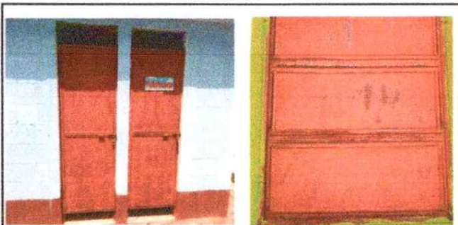
Foto 5: Mantenimiento de estructura
