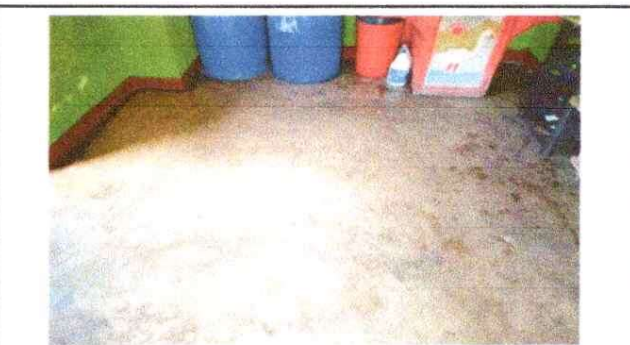
Foto 4: Mejoramiento de piso ceramico en cocina
