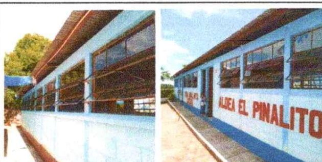
Foto 6: Sustitucion de estructura de metal de ventana
