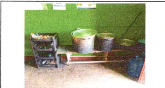
Foto 3: Mejoramiento de mueble de cocina
