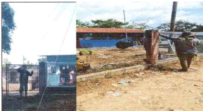
Foto 4: MEJORAMIENTO DE ESTRUCTURA DE SOPORTE DE METAL POR METAL
