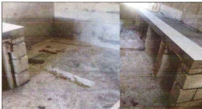
Foto 3: MEJORAMIENTO Mejoramiento de piso de concreto
