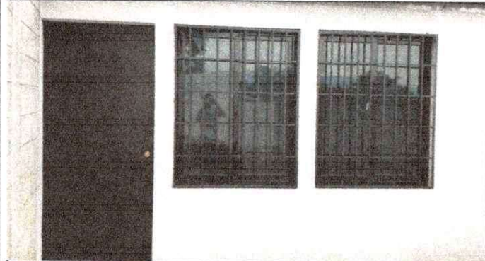
Foto 1: MEJORAMIENTO DE PAREDES DE COCINA, REPELLO Y CERNIDO
