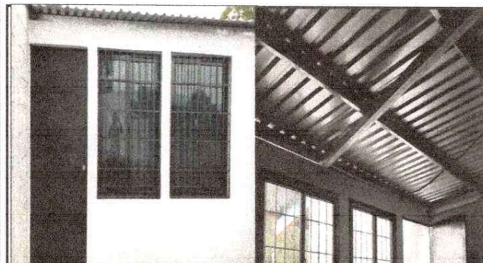
Foto 3: SUSTITUCIÓN DE LÁMINA, POR LÁMINA TROQUELADA ALUZINC CALIBRE 26, SUSTITUCIÓN DE ELEMENTOS DE FIJACION,
