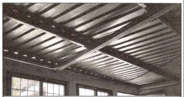
Foto 6: REPARACION DE SISTEMA ELECTRICO, SUSTITUCION DE FOCOS AHORRADORES, TOMACORRIENTES DOBLES
