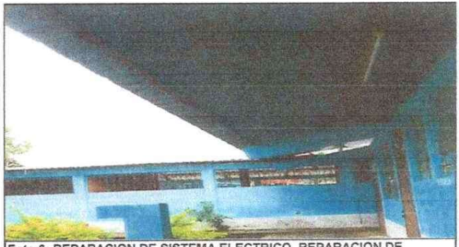
Foto 6: REPARACION DE SISTEMA ELECTRICO, REPARACION DE SISTEMA ELECTRICO, TOMACORRIENTES DOBLES, FOCOS AHORRADORES
