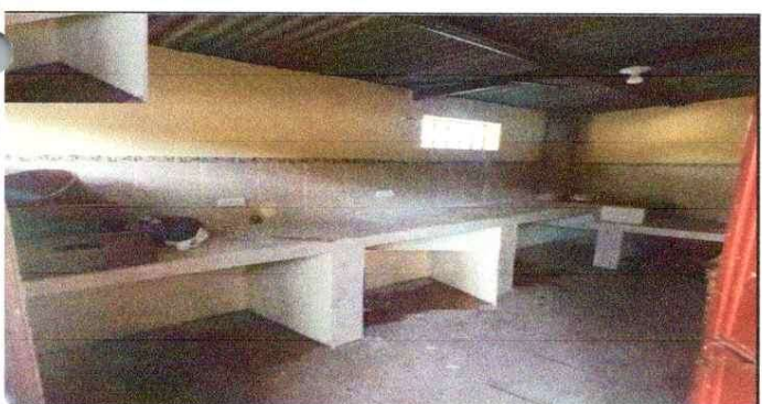
Foto 5: MEJORAMIENTO DE MUEBLE DE COCINA
