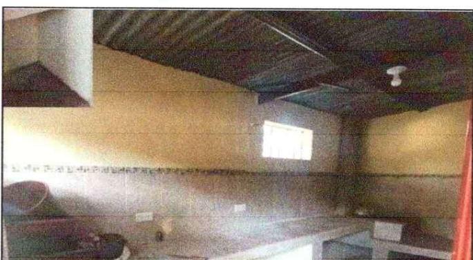
Foto 4: MEJORAMIENTO Y REPARACION DE SISTEMA ELECTRICO
