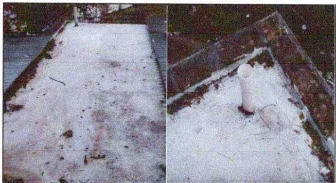
Foto 3: MEJORAMIENTO DE IMPERMEABILIZACION DE LOSA
