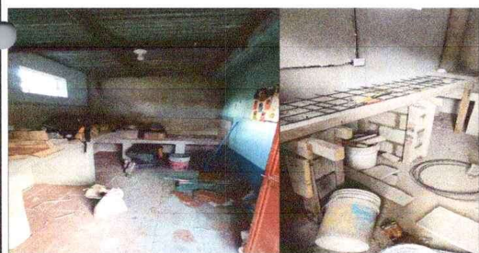
Foto 5: MEJORAMIENTO DE MUEBLE DE COCINA
