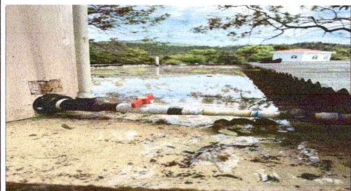
Foto 3: MEJORAMIENTO DE IMPERMEABILIZACION DE LOSA
