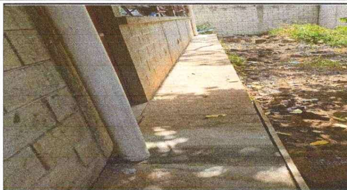
Foto 2: REPARACIÓN DE TUBERIA
