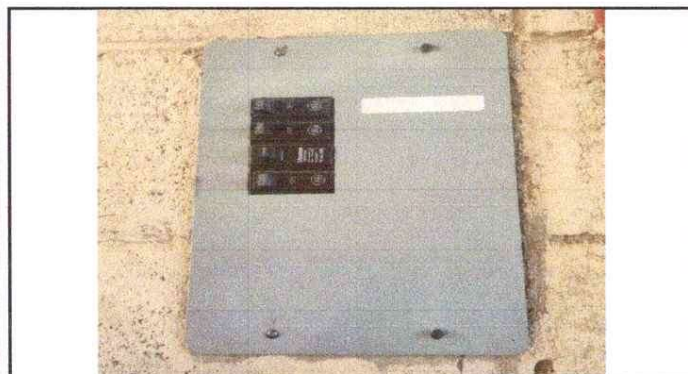
Foto 3: MEJORAMIENTO DE INSTALACIONES ELECTRICAS
