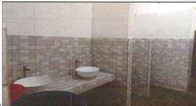
Foto1: MEJORAMIENTO DE SERVICIOS SANITARIOS
