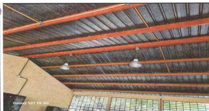
Foto 5: SUSTITUCIÓN DE LAMPARAS
