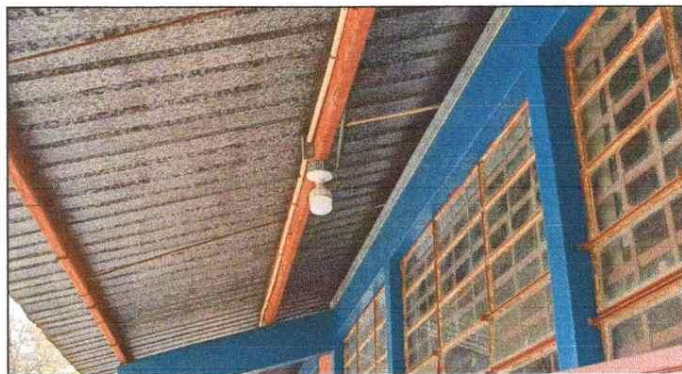
Foto 4: MEJORAMIENTO DE INSTALACIONES DE ILUMINACIÓN (DUCTO Y CABLEADO)
