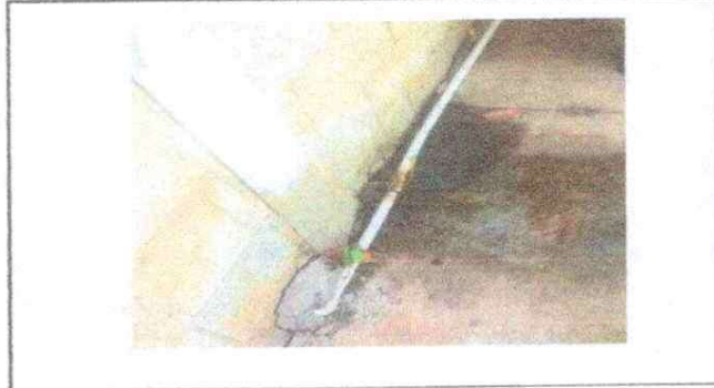
Foto 2: REPARACIÓN DE TUBERIA
