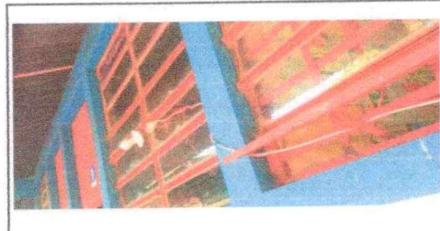
Foto 4: MEJORAMIENTO DE INSTALACIONES DE ILUMINACIÓN (DUCTO Y CABLEADO)
