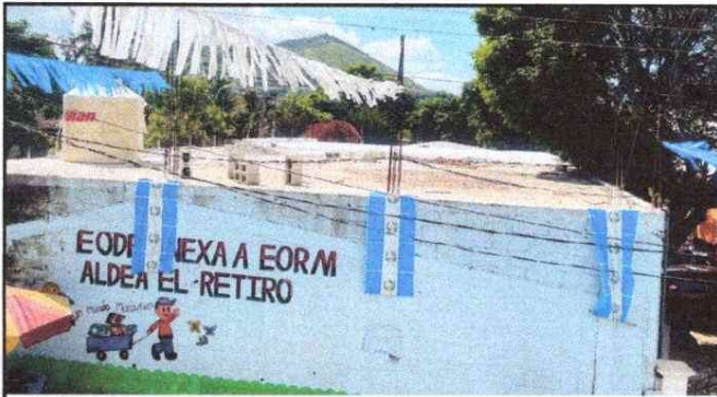
Foto 3: Impermeabilización y repación de pañuelos en losa ya que se filtraba el agua en aula No. 1, afectaba en la salud y proceso enseñanza aprendizaje de los alumnos (as).
