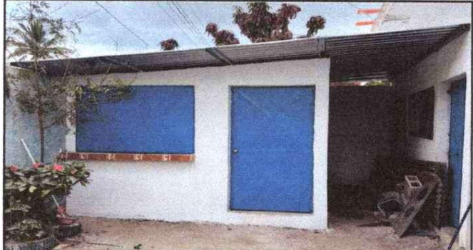
Foto 2: Mejoramiento de cocina que se encontraba en mal estado debido a las inclemencias del tiempo.
