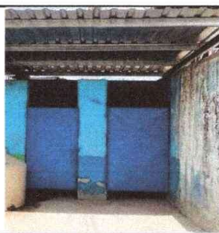
Foto 6: Mejoramiento de puerta de metal en area de baño.
