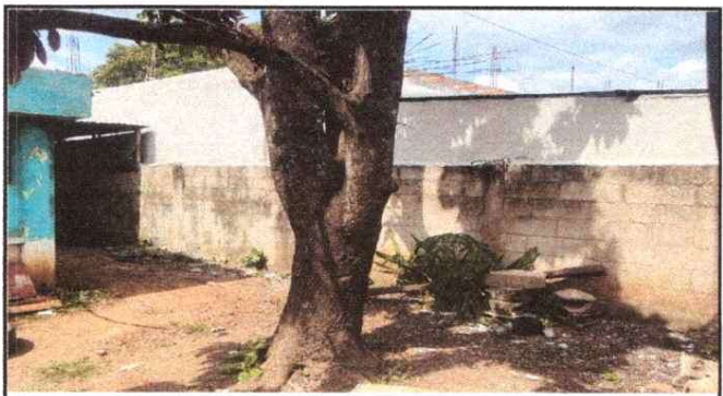
Foto 4: Reparación muro de cocina y mejoramiento de repello gris en muro de cocina. Debido a las constantes lluvias se filtraba el agua, por ello se generaba moño lo cual perjudicaba a la salud de los estudiantes.
