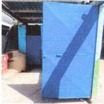
Foto 1: Mantenimiento de chapa en puerta de entrada principal que se encontraba por desprenderse.
