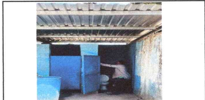
Foto 6: Mejoramiento de puerta de metal en área de baño.
