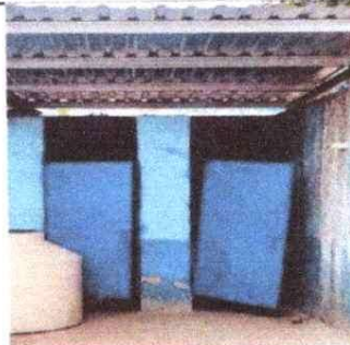
Foto 6: Mejoramiento puerta de baño.
