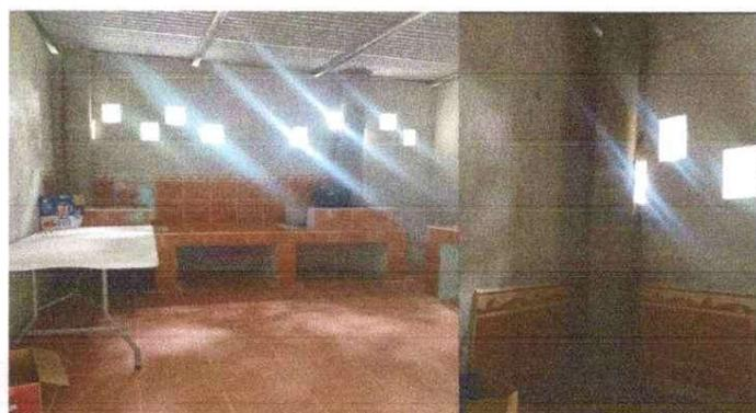
Foto 3: MEJORAMIENTO DE COCINA, SUSTITUCION DE ESTUFA RURAL COMPLETA INCLUYE CHIMENEA Y PLANCHA DE METAL.
