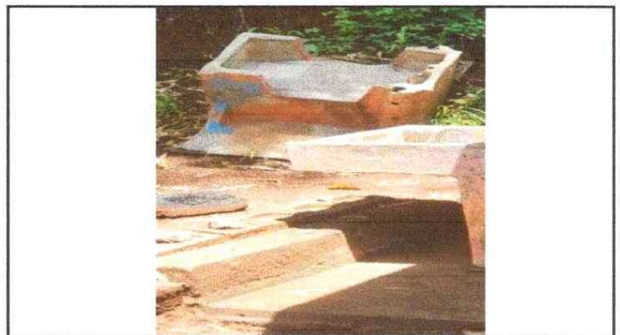
Foto 4: MEJORAMIENTO INSTALACIÓN DE PILA.
