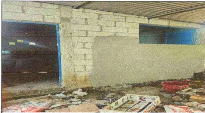
Foto 1: MEJORAMIENTO REPARACIÓN DE REPELLO Y CERNIDO DE PAREDES.
